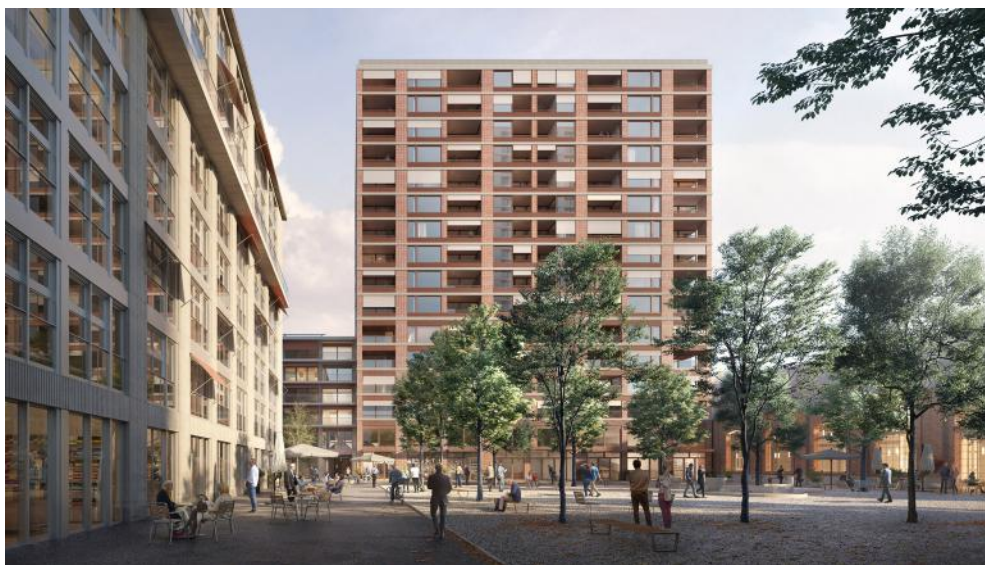
BIGBOY bietet 125 Wohnungen und eine Dachterrasse für die Bewohner*innen..
