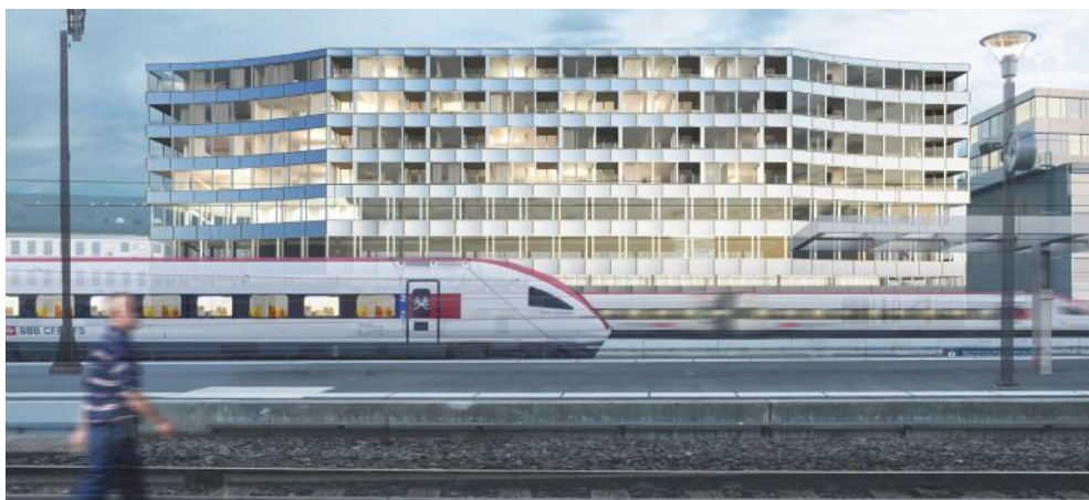
Das Stellwerk 2 entsteht direkt am Bahnhof Winterthur.
